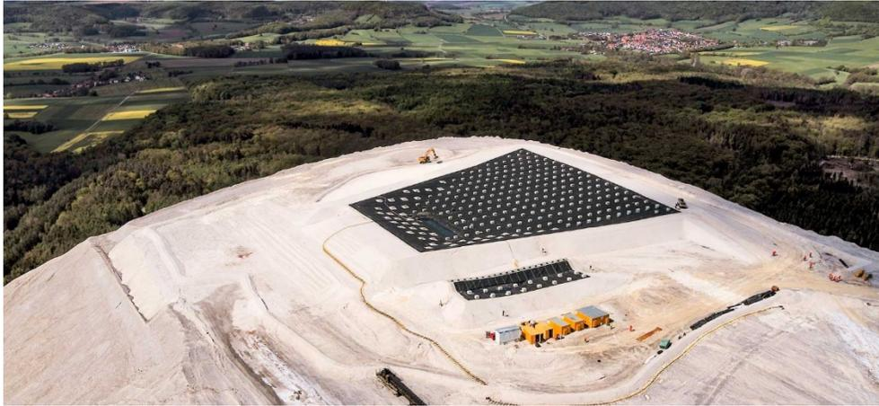
Flankenabdeckung mit Dünnschichtsystem am HVH erprobt und Eignung bestätigt
